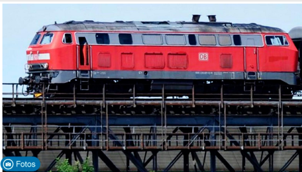
Die Eisenbahnbrücke über den Lech bei Kaufering. Mit der Elektrifizierung soll der Bahnverkehr zwischen Lindau und München deutlich ansteigen.
