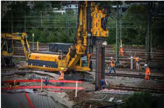
Die Rammarbeiten für Stuttgart 21, hier ein Bild von 2013 aus Untertürkheim, haben die Baustellenanlieger auf die Barrikaden getrieben. Nun wird es in Obertürkheim laut Foto: Achim Zweygarth
