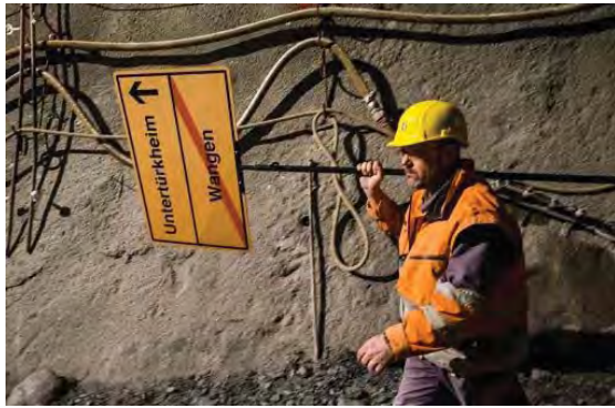
In Wangen und Untertürkheim sind die Auswirkungen des S-21-Tunnelbaus deutlich zu spüren. Foto: Lichtgut/Max Kovalenko
