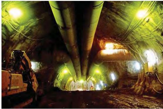
Die Arbeiten in den Röhren unter dem Stadtbezirk Wangen stören die Anwohner der Baustelle. Foto: Lichtgut/Volker Hoschek
