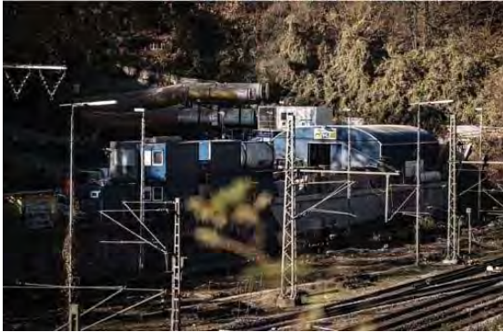
Die Belüftungsanlagen sind zu laut, das sagen Bahn und Anwohner nun gleichermaßen. Foto: Lichtgut/Leif Piechowski
