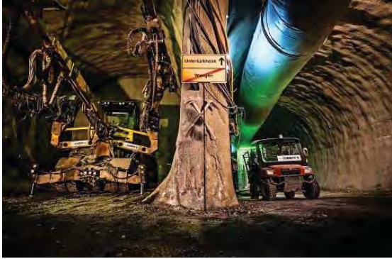
Die Bahn bohrt unter dem Neckar und dem Lindenschulviertel in Untertürkheim ihre Tunnel. Foto: Lichtgut/Max Kovalenko
