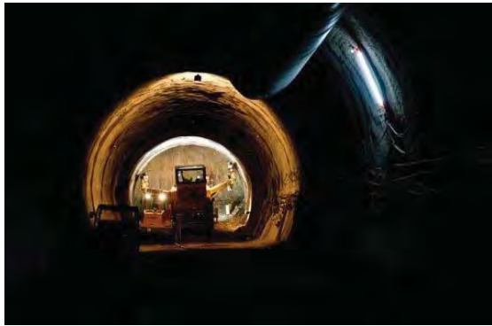
Im Tunnelbau unter Wangen setzt die Bahn auf Bagger und auf Sprengungen. Foto: Lichtgut/Volker Hoschek
