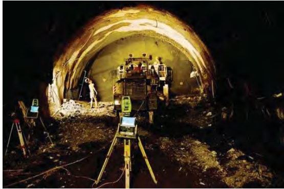
In Wangen wird am Tunnel in Richtung Stadtmitte gearbeitet. Foto: Lichtgut/Volker Hoschek
