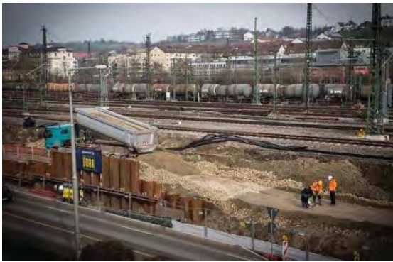
Der Lärm auf der Baustelle für Stuttgart 21 wird am Wochenende und in einigen Dezembarnächten anhalten. Foto: Achim Zweygarth
