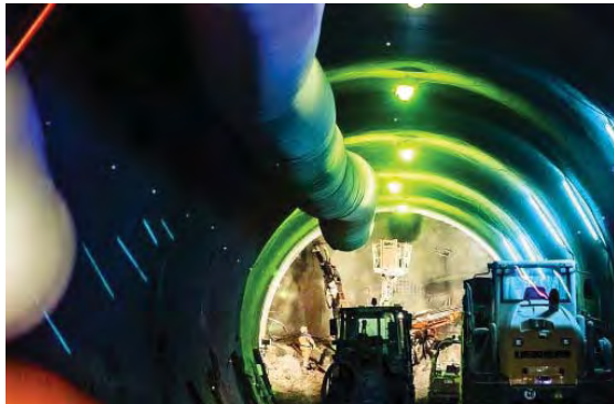
Die Belüftung der Tunnel sorgt außerhalb für zu hohe Lärmwerte Foto: Lichtgut/Max Kovalenko
