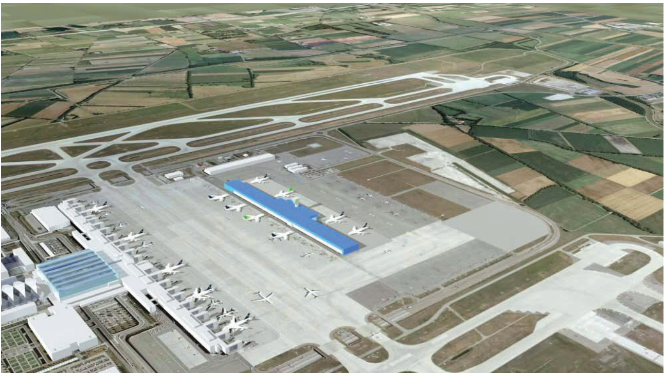
Der hier blau markierte Satellit östlich von Terminal 2 (ganz links im Bild) ist im Bau.
